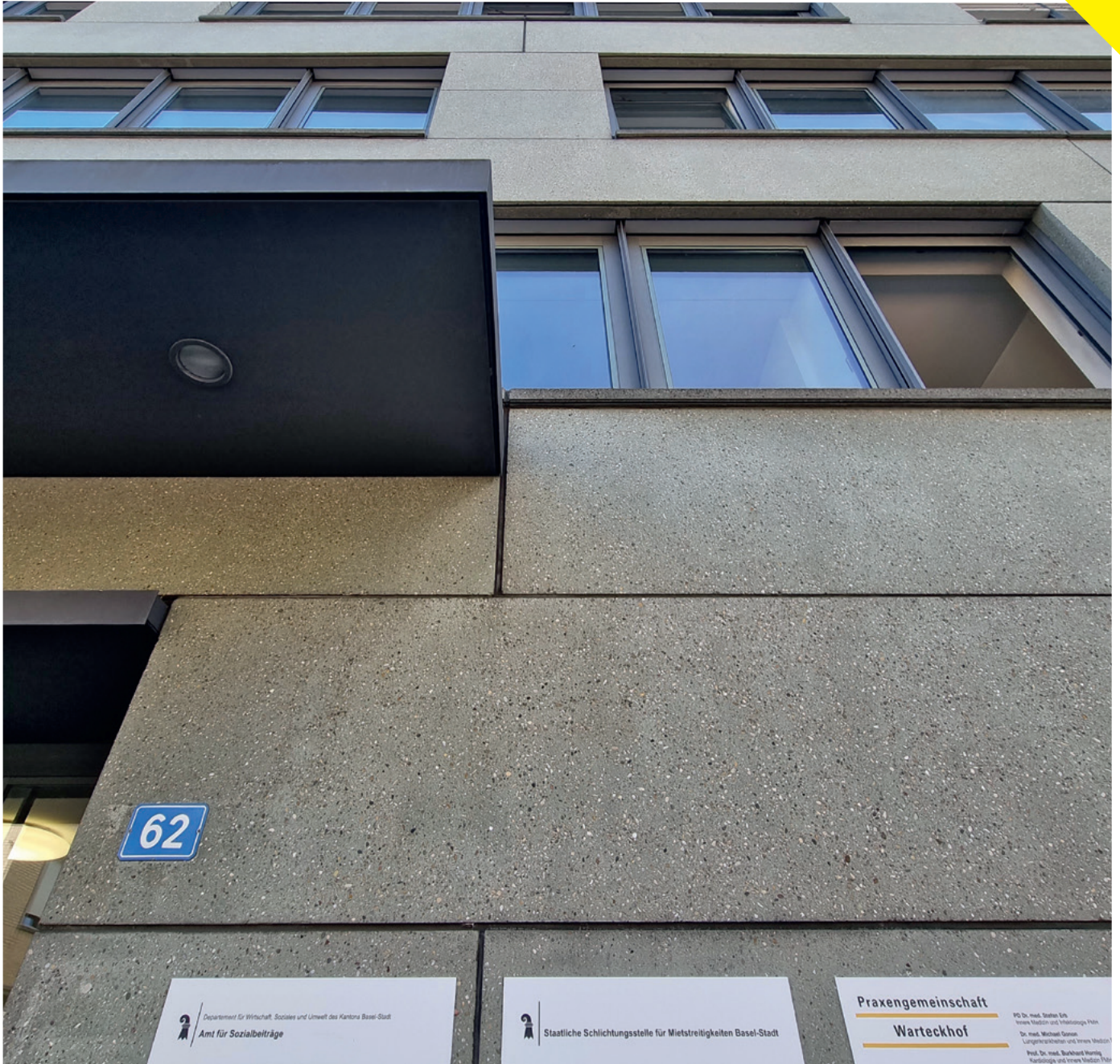
Keine mietfreundliche Adresse: Schlichtungsstelle an der Grenzacherstrasse 62
