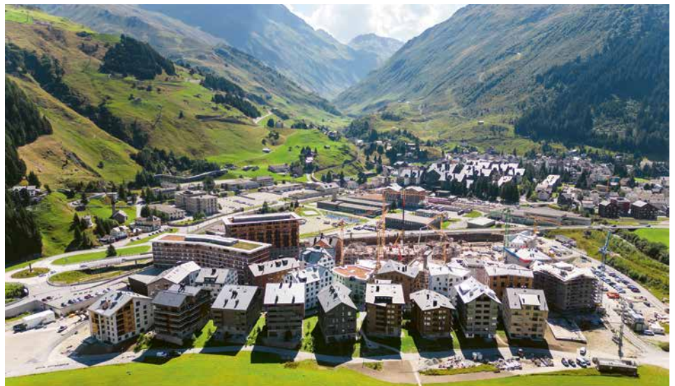
In Andermatt fehlen Wohnungen für Einheimische und Hotelangestellte.
